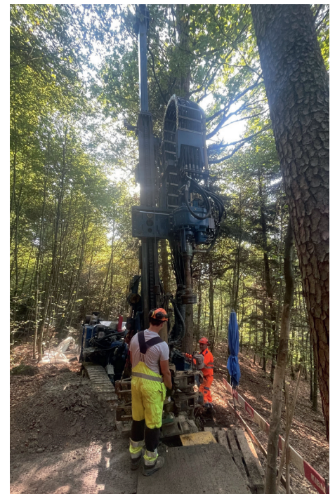
Sondierbohrungen für die Oberlandautobahn
